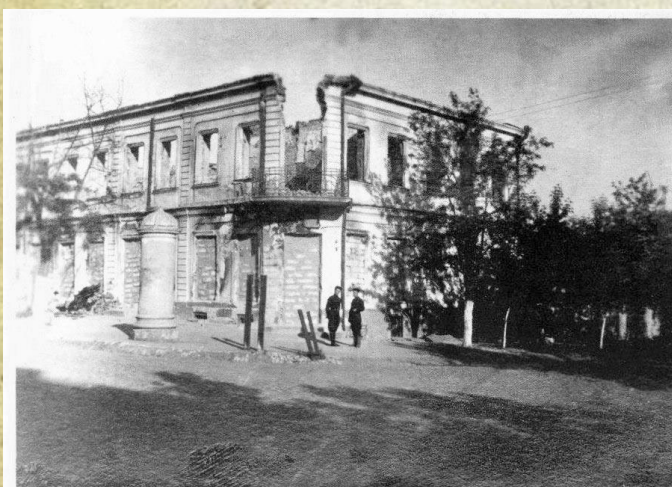
г. Херсон. Разрушенное здание на перекрестке улиц Суворова и Карла Маркса.
